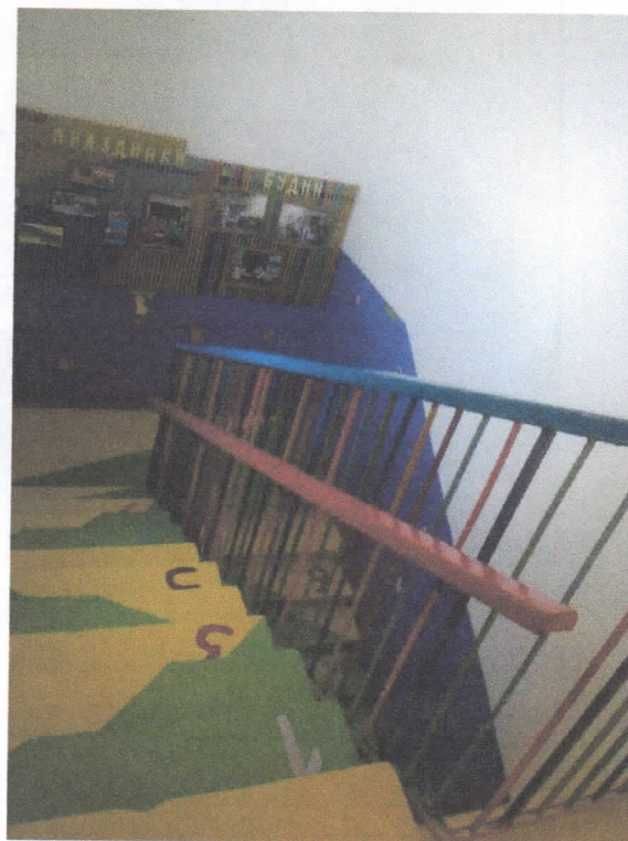
Фото 10, 11 – Лестница внутри здания
