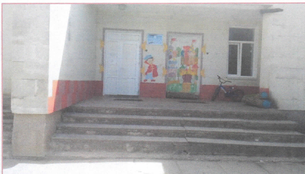
Фото №5 – Вход в здание
